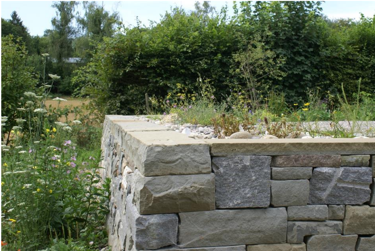
(Abb. 8, Trockenmauer, Foto: P. Schlachter)
