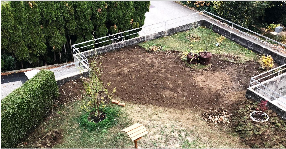
Anfangsstadium über den eigenen Garagen
