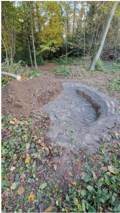
Grube mit Sand ausgekleidet
