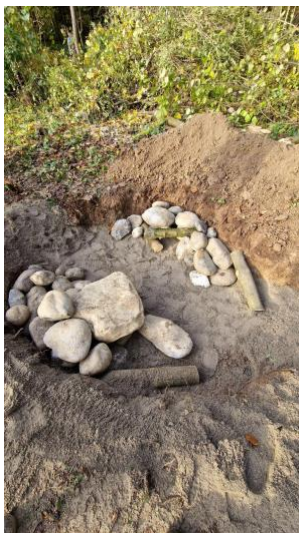
Eingebaute Holzstrukturen um größere Hohlräume zu erzeugen
