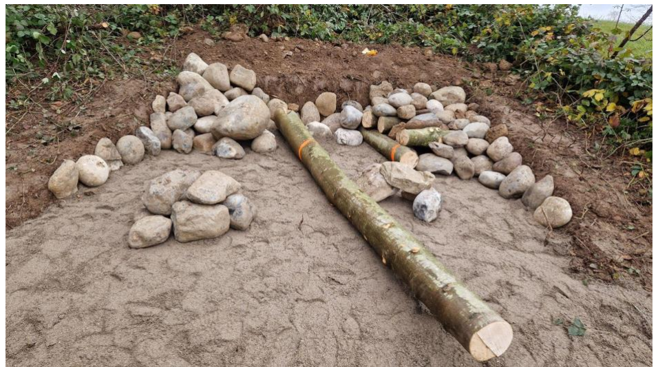
Eingebaute Holzstrukturen um größere Hohlräume zu erzeugen
