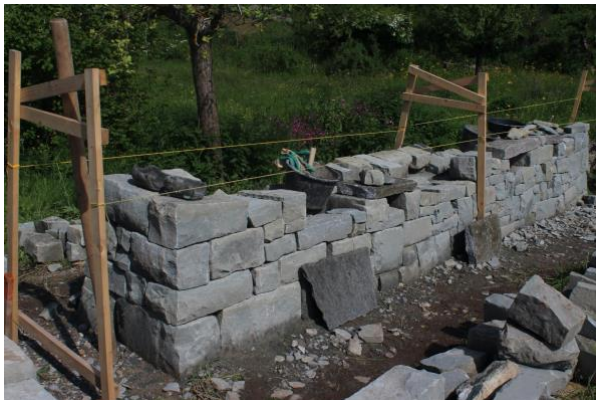
Trockensteinmauer während Bauarbeiten
