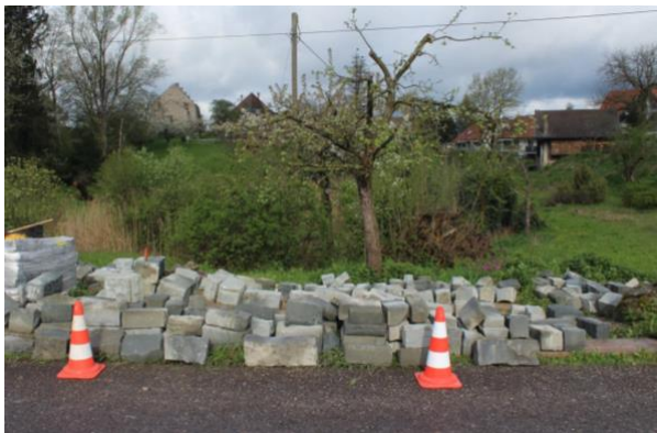
Anordnung der Mauersteine vor Baubeginn
