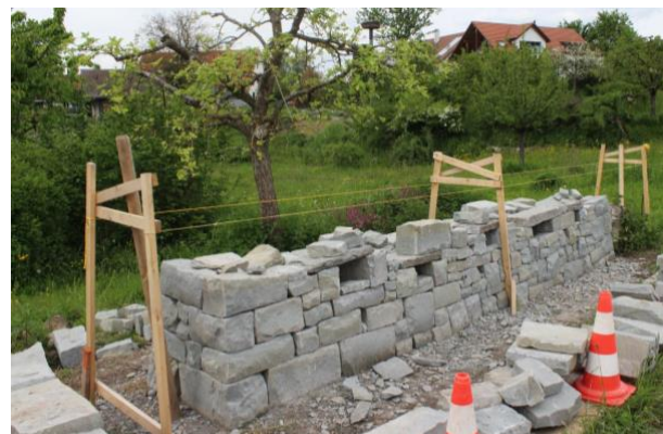
Trockensteinmauer am fünften Arbeitstag
