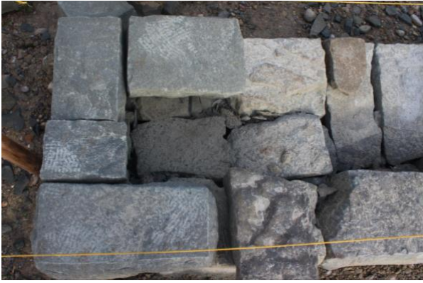
Hintermauerungsprozess
