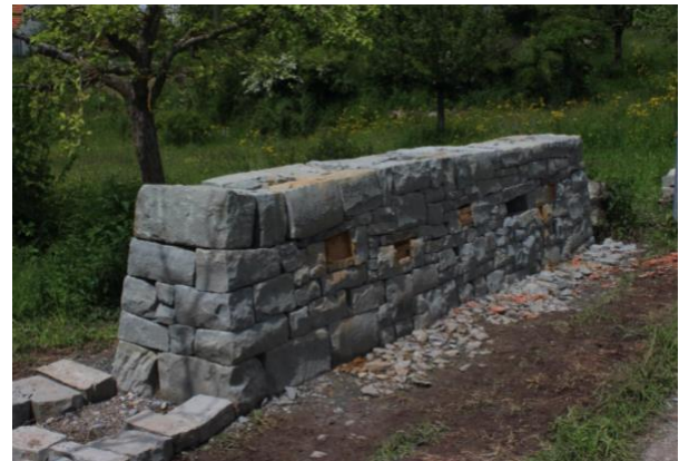
Trockensteinmauer nach Schluss der Baustelle
