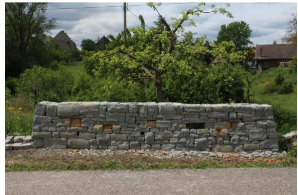
Trockensteinmauer nach Arbeitsabschluss
