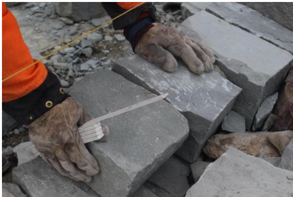
Sorgfältige Bemessung jedes Mauersteines
