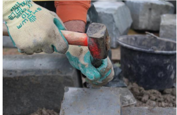
Bearbeitung der Mauersteine
