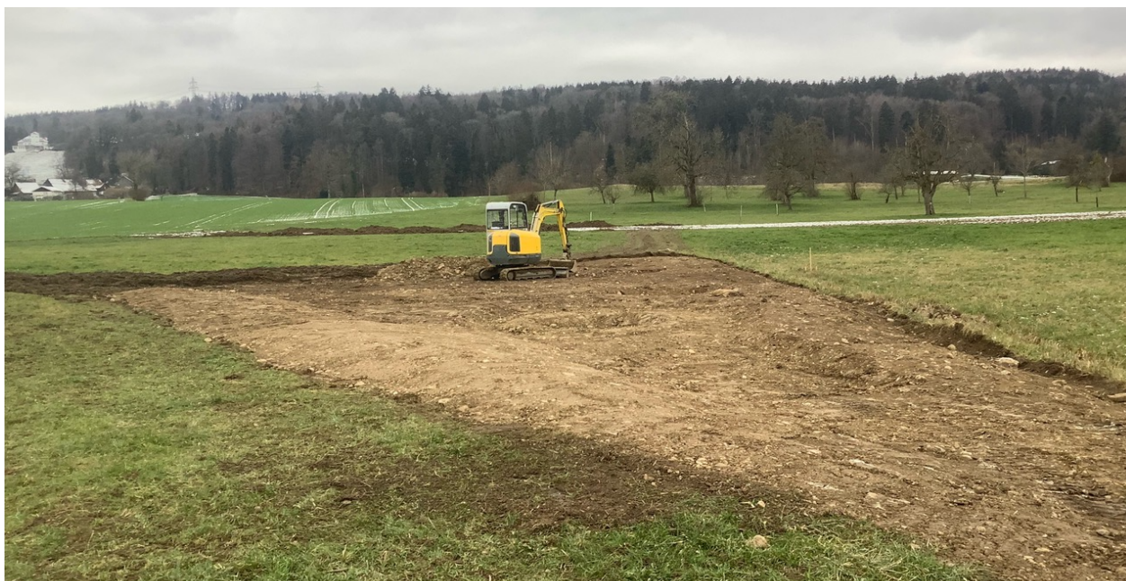
Oberbodenabtrag und Geländemodellierung in Zusammenarbeit mit Gartenbauer und Landwirt.
