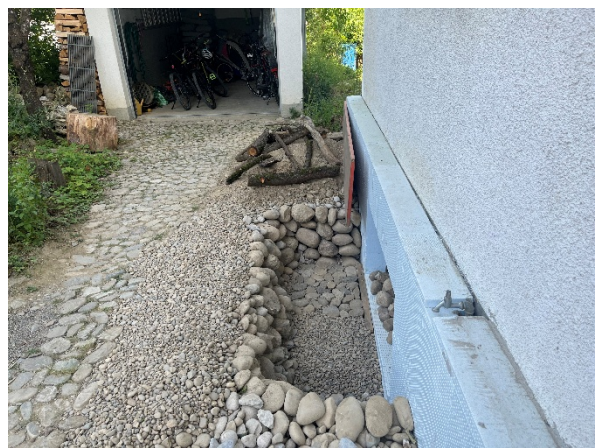
früher asphaltierter Garagenplatz heute Baustelle für gepflasterter Platz
